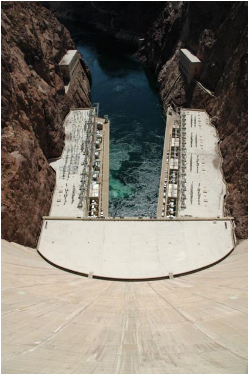
Figure 4.41. Kilátás a Hoover-gátról. Az amerikai iparosodás ezen emblematikus építménye 17 turbinája révén 2000 MW beépített kapacitással rendelkezik, és elsősorban Las Vegas áramellátását szolgálja (Boulder City, Nevada, USA, Trócsányi A. felvétele)
