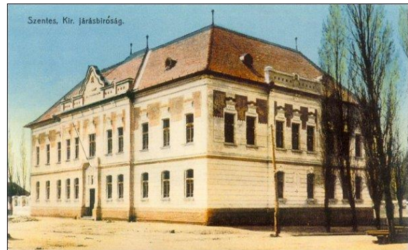
A Szentesi Kir. Járásbíróság épülete, amelyben 1912-ben kezdhetette meg működését a bíróság
