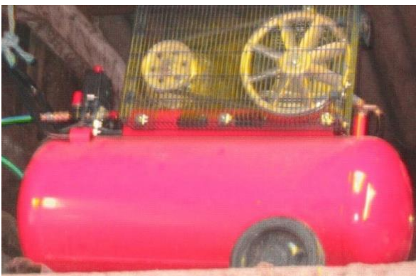
9. kép Kompresszor(saját kép).
