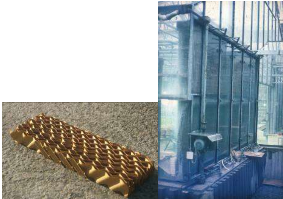
3. ábra Hűtőfaltöltet, üvegsaluval határolt hűtőfal technológiája növényházakban [LÁNG Z. , 1999]
