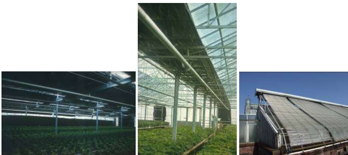
6. ábra Sötétítő ernyővel történő megvilágítási érték beállítás [LÁNG Z., 1999]
