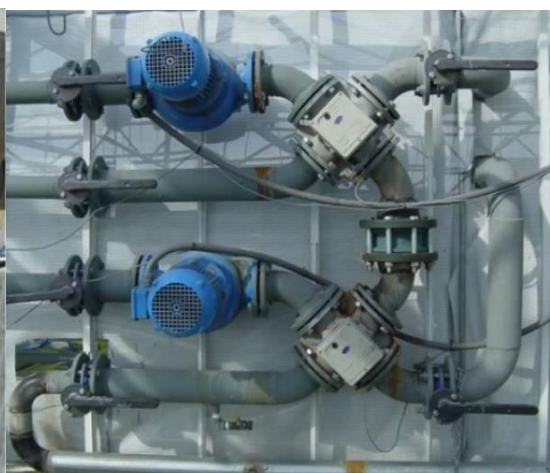
12. kép Négyjártatú keverőszelep[3]
