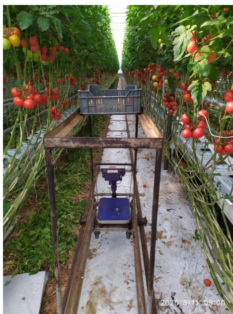
9. kép Vegetációs fűtés csővezetéke, mint szedőkocsi pálya (ÁRPÁD-AGRÁR ZRT. SZENTES, saját kép)
