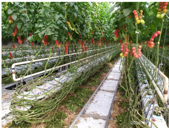
2. kép Fűtésrendszer ÁRPÁD-AGRÁR ZRT. SZENTES, saját kép
