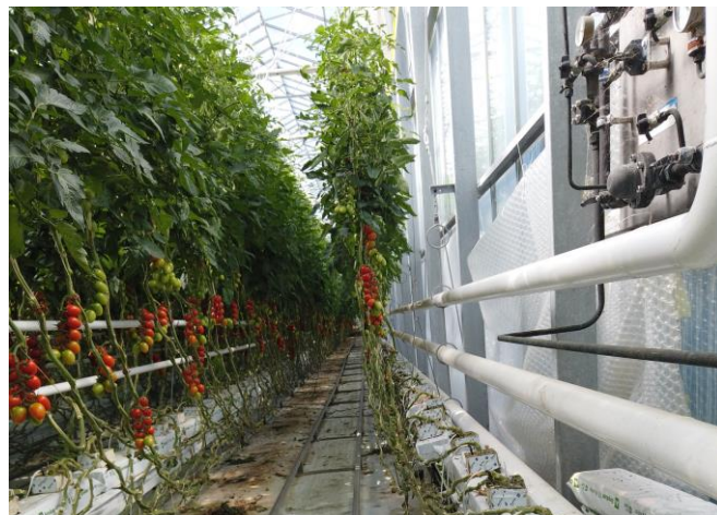
5. kép Légtérfűtés sima cső hőleadókkal (ÁRPÁD-AGRÁR ZRT. SZENTES, saját kép)
