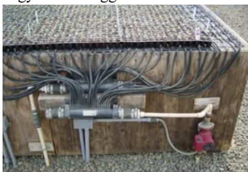
4. kép Előremenő osztó [1]
