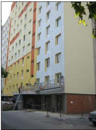
8.1. kép: Szegedi panelházak külső fal felújítása és nyílászáró cseréje (2010)
