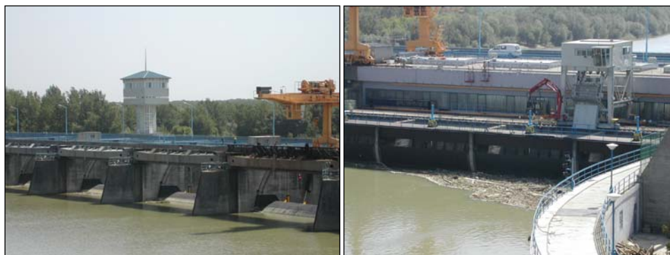
10.38–10.40. kép: A kiskörei vízerőmű modellje, billenő szegmensei és uszadék tisztítója
