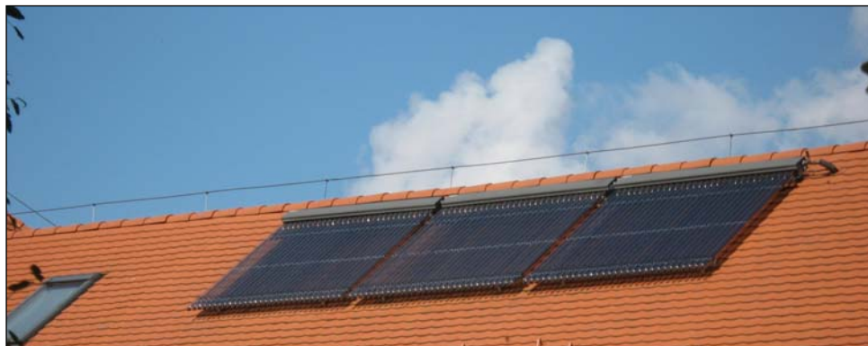
9.4. kép: Vákumcsöves napkollektor: Hortobágyi Nemzeti Park Látogatóközpont
