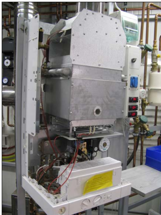
13.8. kép: Gázkazán szerelés alatt
