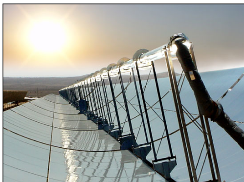
10.28. kép: Parabola teknős naperómű hőgyűjtő rendszere
