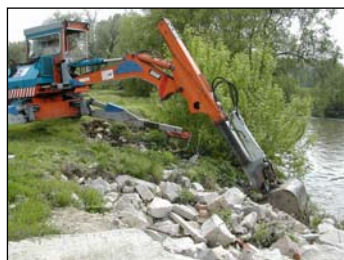
10.41–10.45. kép: Mini vízerőmű a Nyitra folyón, partfal karbantartása
