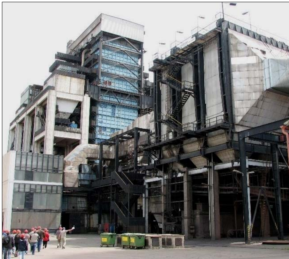
10.1. kép: Erőművi blokk: kazán, szénőrlő malom
