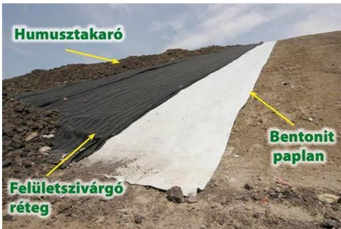
23. ábra Az oldalfelület zárószigetelésének rétegei (euprojekt.karcag.hu)
