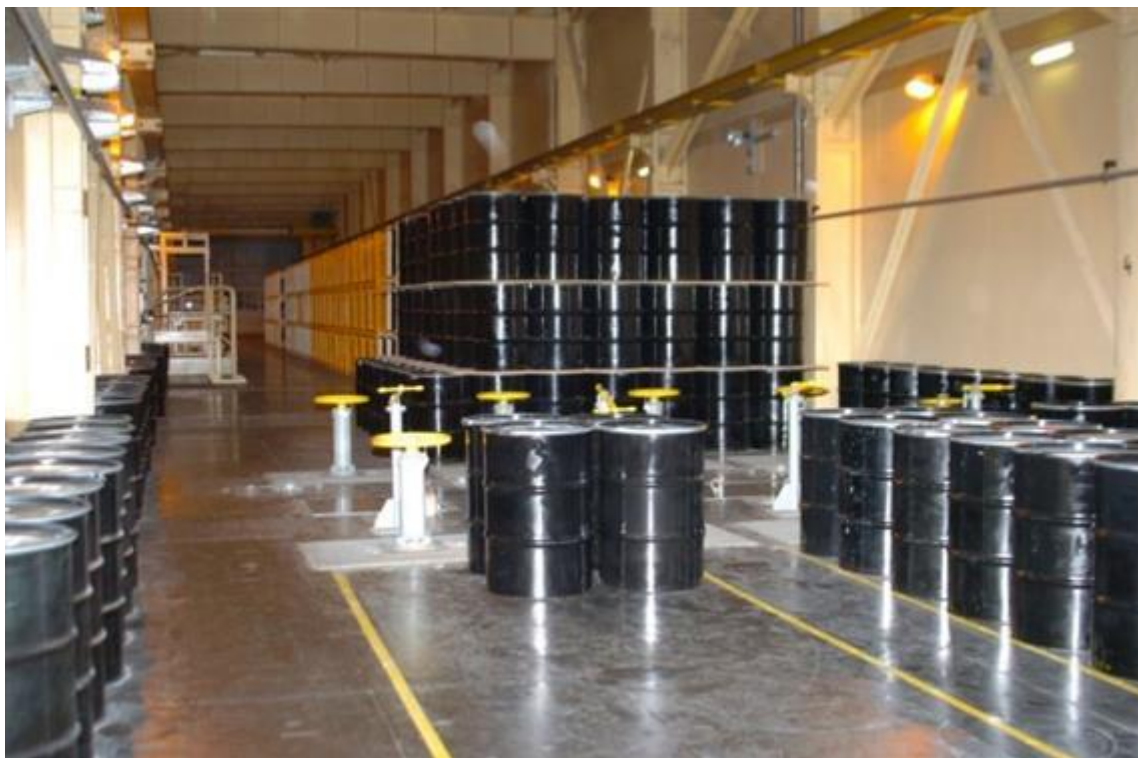
62. ábra Kis aktivitású hulladék átmeneti tárolása (atomeromu.hu/hulladekkezeles)
