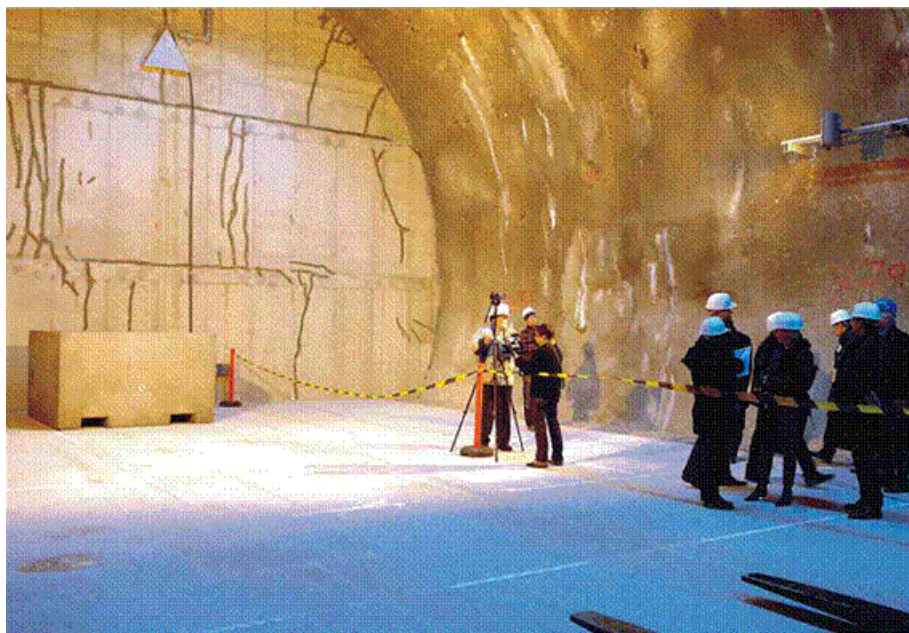
65. ábra A Nemzeti Radioaktív hulladék-tárolóban elhelyezett első, kilenc hordót tartalmazó beton konténer (www.rhk.hu)
