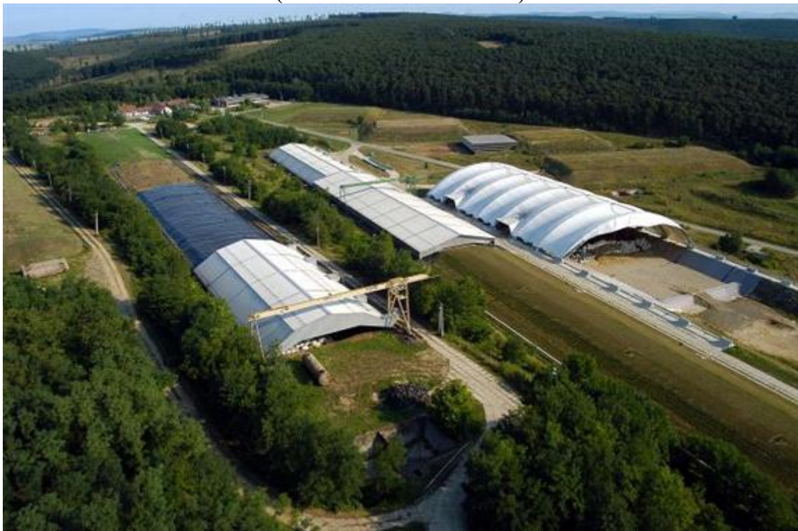
59. ábra A lerakó már betelt részén a rekultivációs munkák elkezdődtek (a felső végén már a füvesítés is megtörtént, a középső részen a takarórétegek felvitele történik, míg az alsó végén még tartanak az elhelyezési munkák) ( www.saubermacher.hu/web/hu/ )
