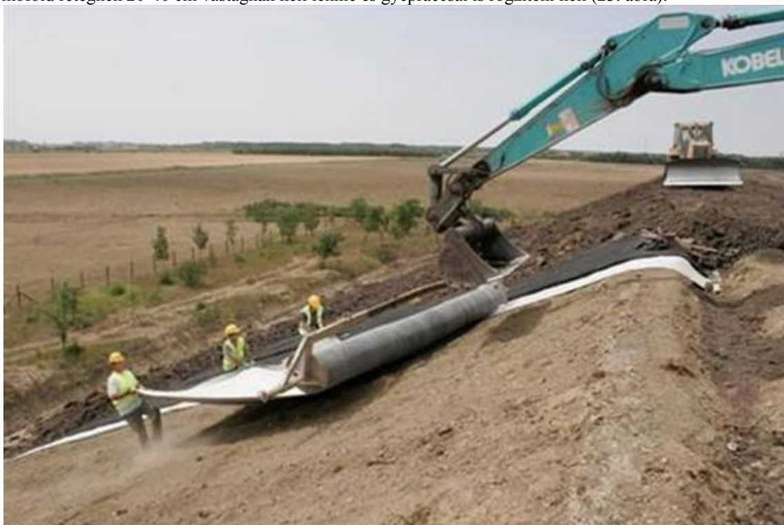
22. ábra Bentonit szigetelő paplan fektetése (euprojekt.karcag.hu)
