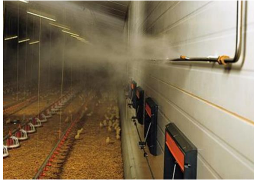
27. ábra: Belső vízporlasztásos rendszer [26]
