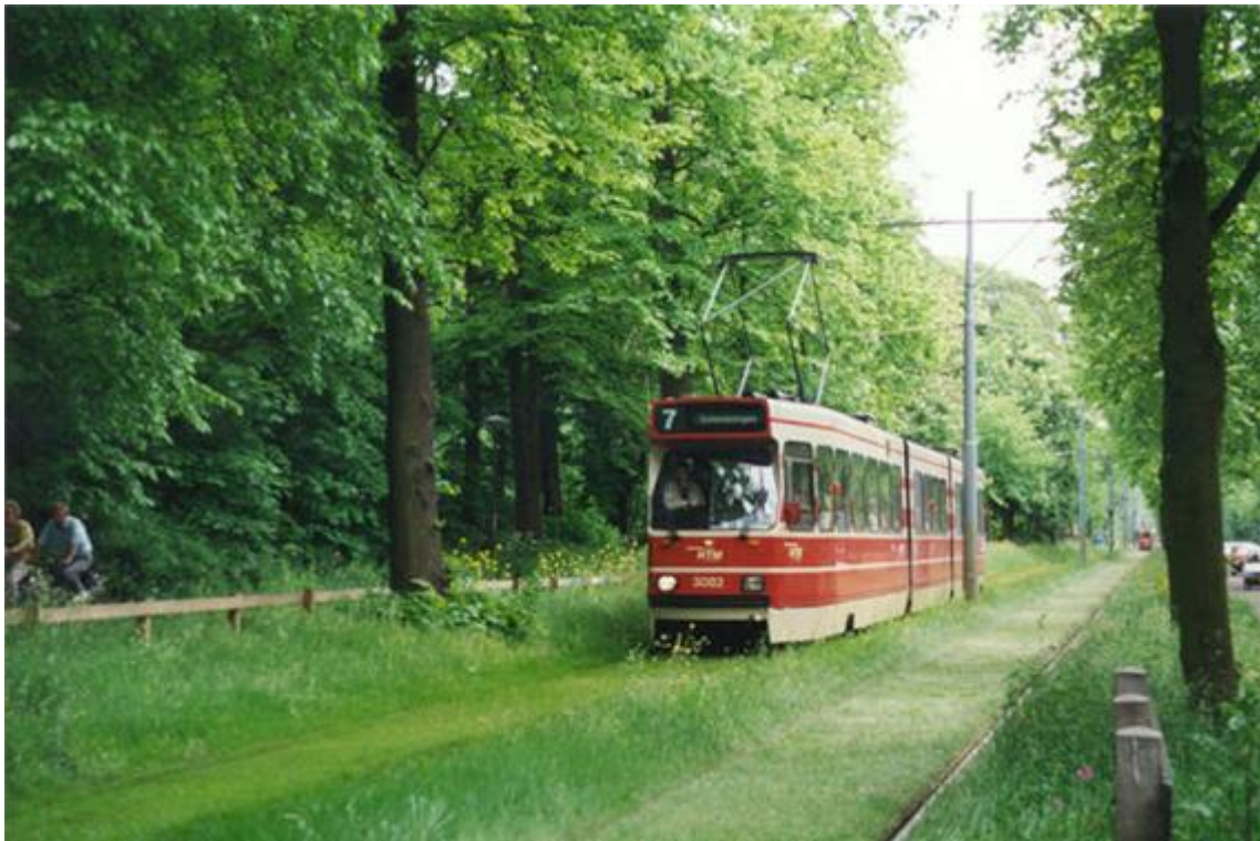
8.3. ábra Nyílt villamospálya befűvesítése Hágában
